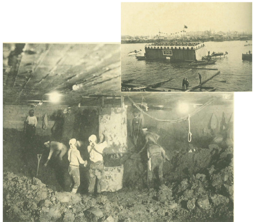
（右上）橋脚潜函工事第一回潜函進水（下）橋台潜函内部作業
