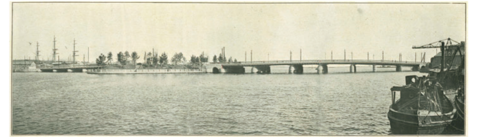
施工：国（復興局） 型式：上路型突桁式鋼筋桁、上路型鋼筋単桁 橋長：大橋/145.974m 小橋/45.822m 橋幅：大橋/21.996m 小橋/21.996m 着工：大正13年8月15日 竣工：大正15年11月20日 開通式：大正15年11月22日 現在の橋：平成12年架設
