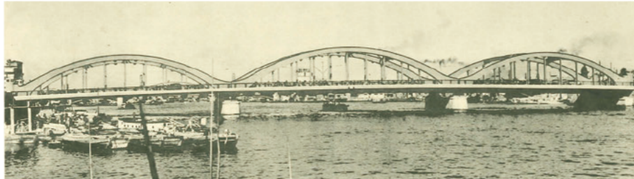
施工：東京市 型式：下路型鋼筋繫拱 橋長：152.000m 橋幅：22.000m 起工：大正15年9月 竣工：昭和4年9月
