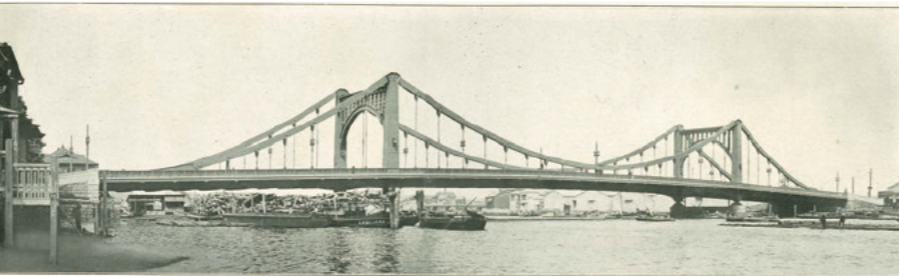
施工：国（復興局） 型式：鋼吊橋 橋長：186.600m 橋幅：22.000m 着工：大正14年3月19日 開通式：昭和3年3月15日
