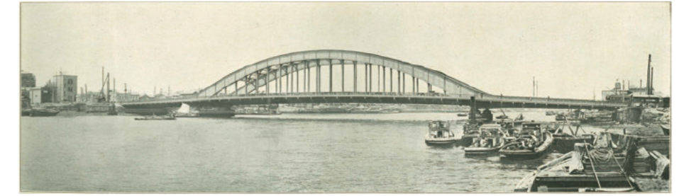
施工：国（復興局） 型式：下路型突桁式鋼筋繫拱（中央）及鋼筋単桁（両側） 橋長：185.166m 橋幅：22.048m 着工：大正13年12月1日 開通式：大正15年12月20日
