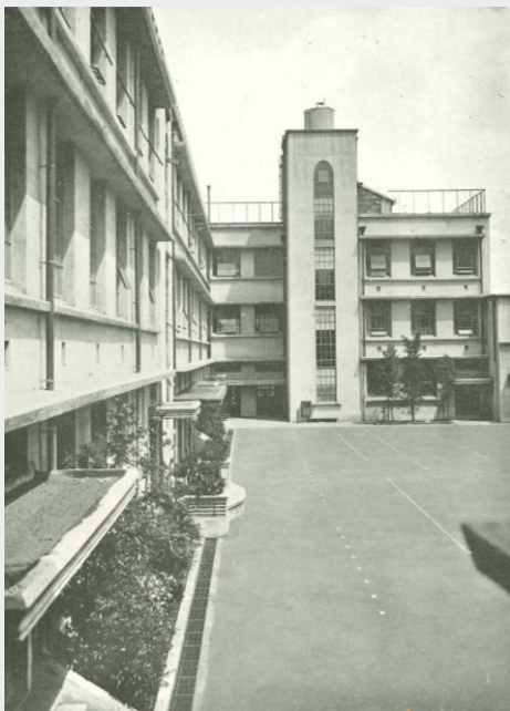
くろもん 黒門小学校 台東区上野 昭和5年(1930)竣工
