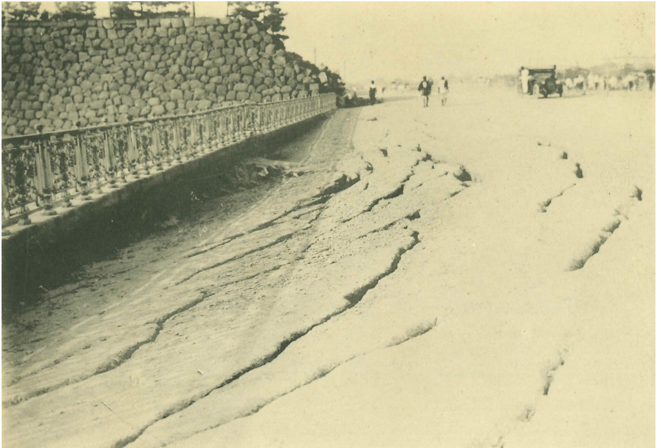
凱旋道路の亀裂（『東京震災録』写真帖及附図）
